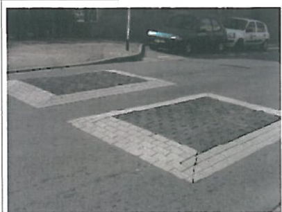
Source : Cete de l'Est(10)
